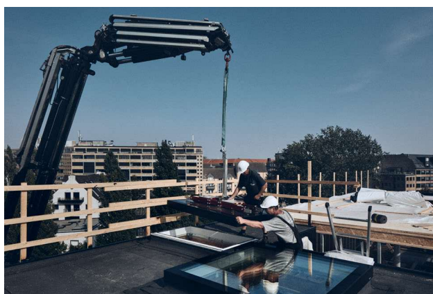
Umieszczanie jednostki górnej
